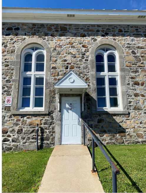
Couvre toit de porte d'entrée avec boiserie ouvragée
