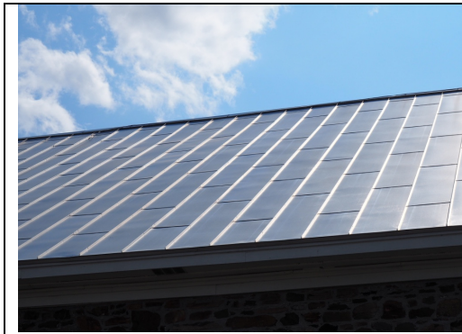
Tôle pincée de la toiture principale
