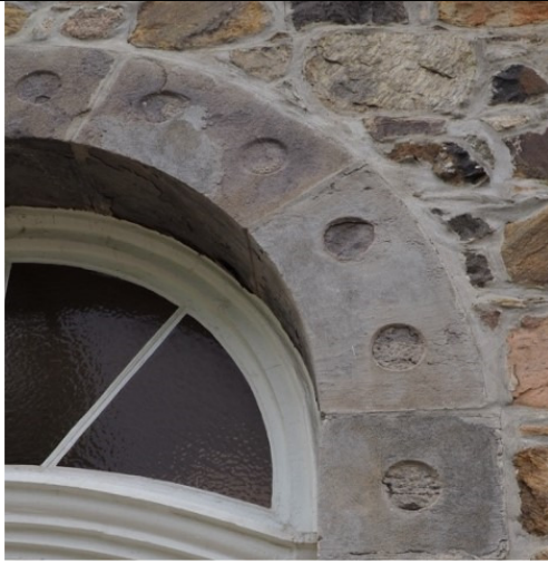
Motifs incrustés du linteau arqué de la porte principale
