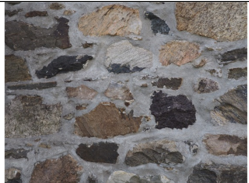
Maçonnerie de pierre à moellons ébauchés à appareil assisé
