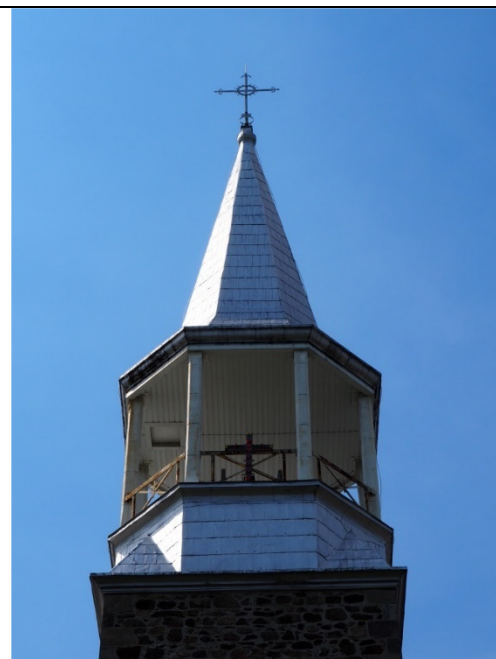
Clocher à lanterne simple abritant une cloche et couronné d'une flèche pyramidale à croix
