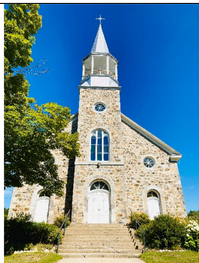
Grand escalier en béton à trois faces de l'entrée principale
