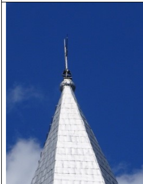
Tôle en plaques clocher
