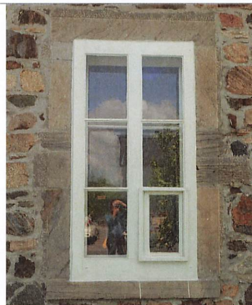
Fenêtre à battants et contre-fenêtre à carreaux en bois avec chambranle, linteau et allège en pierre de taille
