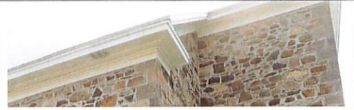
Corniche en boiserie ouvragée
