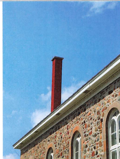
Cheminée en brique d'argile rouge
