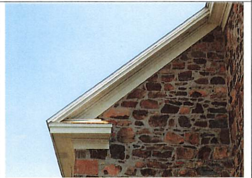
Retour d'avant-toit esquissant un fronton sur la façade principale
