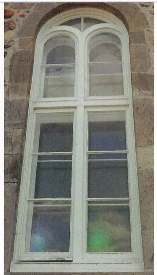
Menneaux et cadre de fenêtre en boiserie ouvragée
