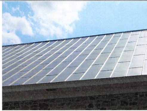
Tôle pincée de la toiture principale
