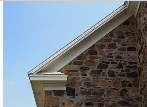
Retour d'avant-toit esquissant un fronton sur la façade principale
