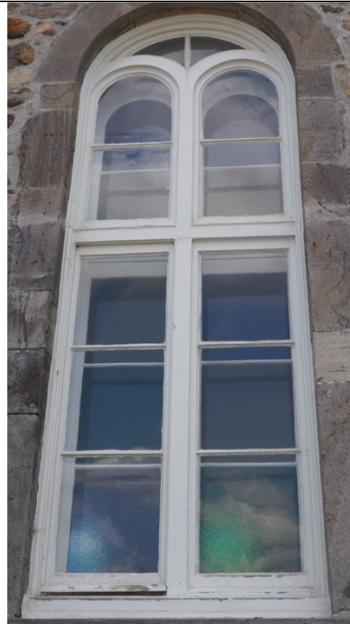
Menneaux et cadre de fenêtre en boiserie ouvragée
