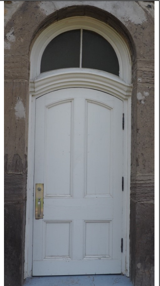
Porte à caissons et imposte en boiserie ouvragée
