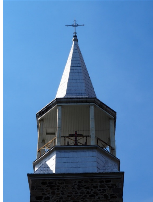
Clocher à lanterne simple abritant une cloche et couronné d'une flèche pyramidale à croix
