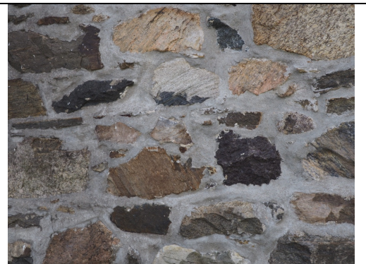
Maçonnerie de pierre à moellons ébauchés à appareil assisé
